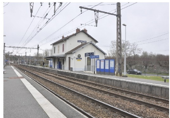
Gare de Fontaine-le-Port
